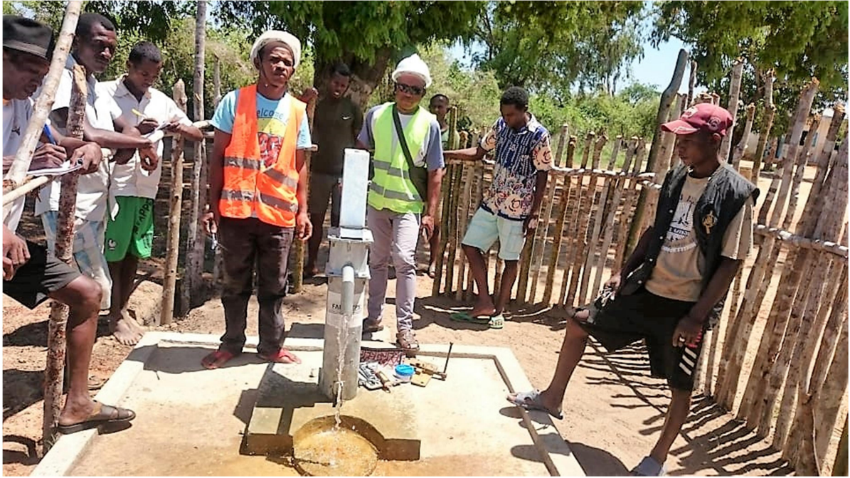
Forage de l'EPP Beroboka
