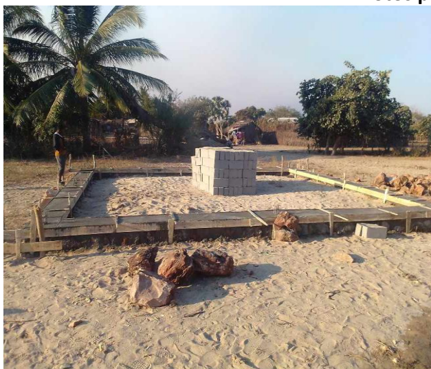
La construction de la nouvelle classe en cours
