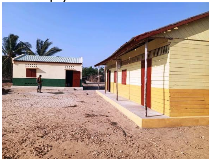
EPP Ampasimaty rénovée et agrandie
